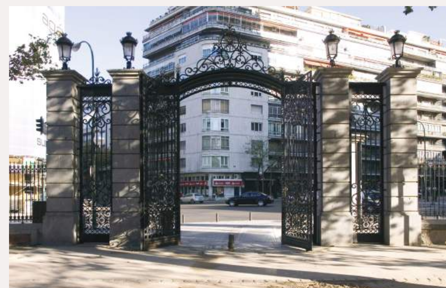
Una de las obras de los trabajadores de Talleres del Retiro fue el montaje en el parque de la Puerta de O'Donnell, procedente del desaparecido Palacio de Anglada o Palacio de Larios.
